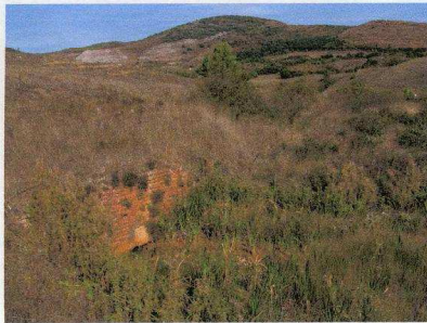
Foto 3 Boca de salida del canal (inundada). Canal de Orbó. 2006
